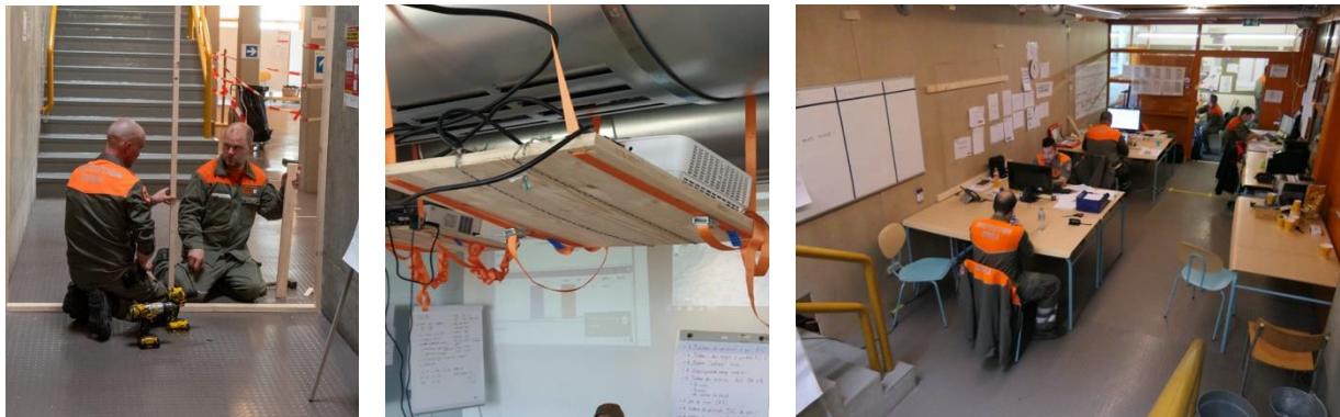
Figure 10 : Installation et exploitation du PCR (poste de commandement régional)
