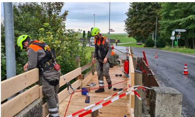
Figure 6 : Réfection de la passerelle de St-Barthélémy
