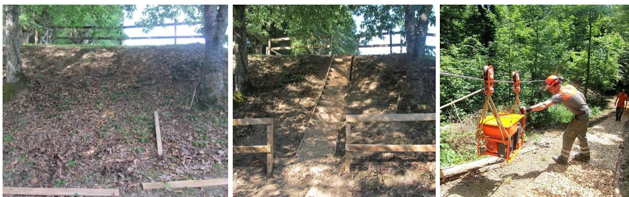
Figure 6 : « Avant – Après » et utilisation de tir-câble pour le transport de matériel lourd
